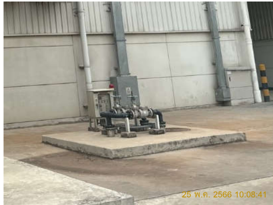
รูปถ่ายที่ 3.2-3 : เครื่องจักรติดตั้งบนฐานคอนกรีตเพื่อลดเสียงดัง
