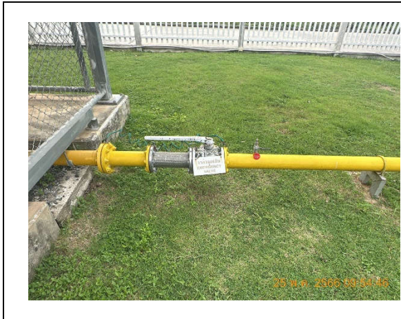
รูปถ่ายที่ 3.2-50 : ป้ายแสดงทิศทางการหมุนวาล์ว และแสดงทิศทางการไหลในท่อขนส่ง
