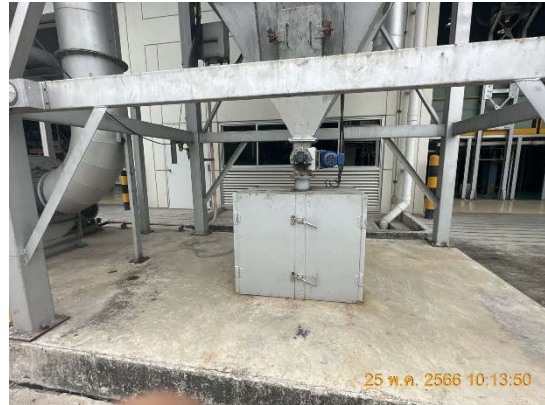
รูปถ่ายที่ 3.2-28 : ถังเหล็กเก็บฝุ่นอะลูมิเนียม จากระบบดักฝุ่นแบบถุงกรอง
