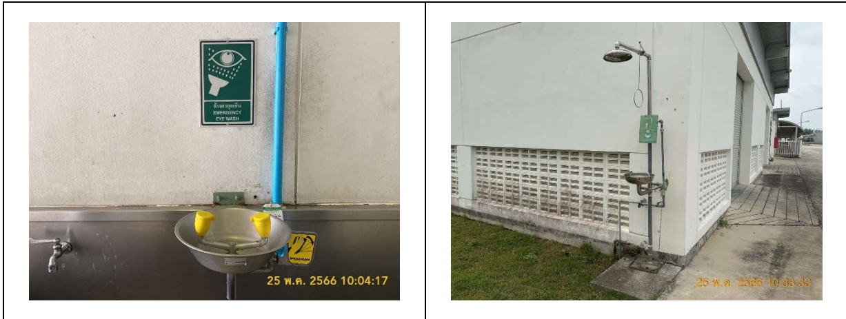
รูปถ่ายที่ 3.2-40 : ฝักบัวฉุกเฉินและอ่างล้างตา
