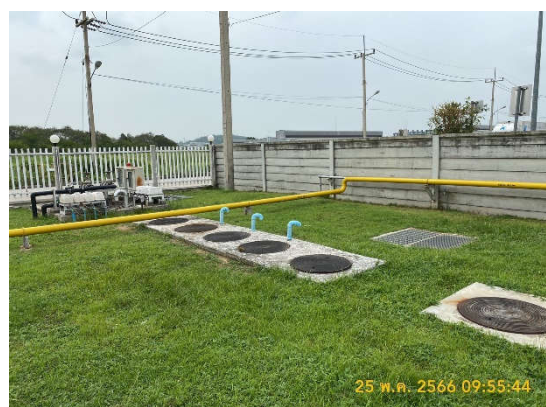
รูปถ่ายที่ 3.2-14 : ระบบบำบัดน้ำเสียสำเร็จรูป
